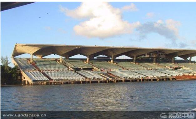
这座建筑完全用浇筑水泥建成，有着巨大的悬垂褶皱屋顶，深受迈阿密居民的喜爱。1992年被安德鲁飓风吹毁后，一直被开发商盯着的体育场被迫关闭，并经受了多年的肆意破坏。
