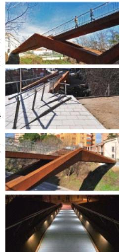
介于这些原因，人行天桥的造型受其跨域的道路沟渠不对称形状的强烈影响。探寻出这样一种设计方案：突出由沟渠两岸不同高度而造就的不对称特点（因为Terra Alta区一侧的沟渠沿岸比can Gili区那一侧高出4.3米），并在沟渠南侧设置一个小平台。
